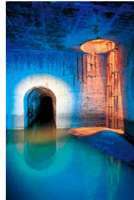
煉瓦下水道流入口
