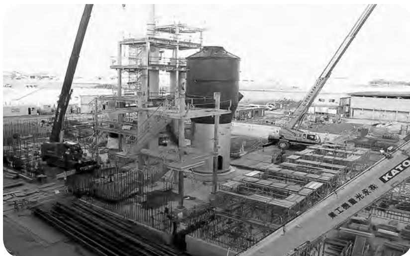
建設中の3号炉（完成時は建屋内）
