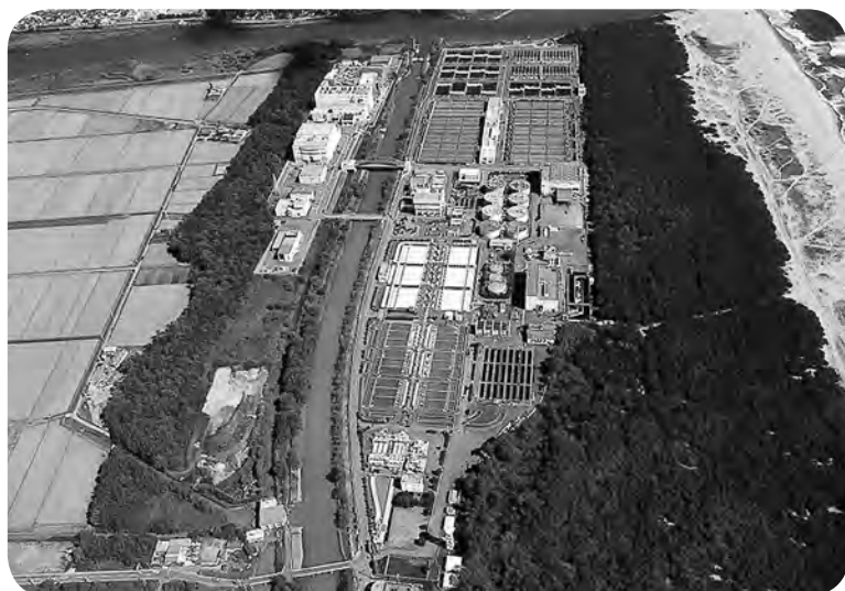
南蒲生浄化センター 震災前全景（上：七北田川）
