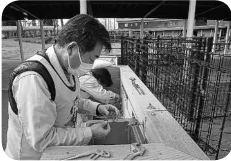
給水栓の整備の様子
