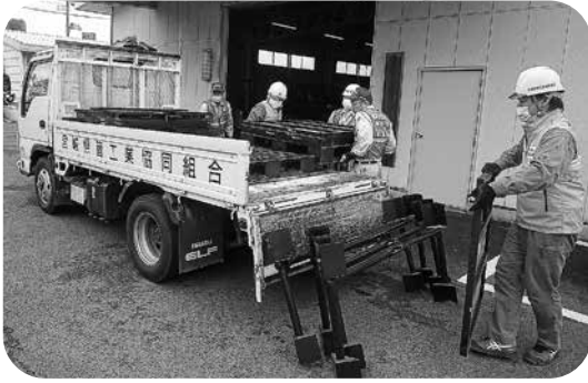
仮設水槽積込
