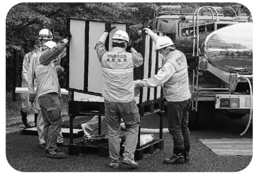
仮設水槽組立
