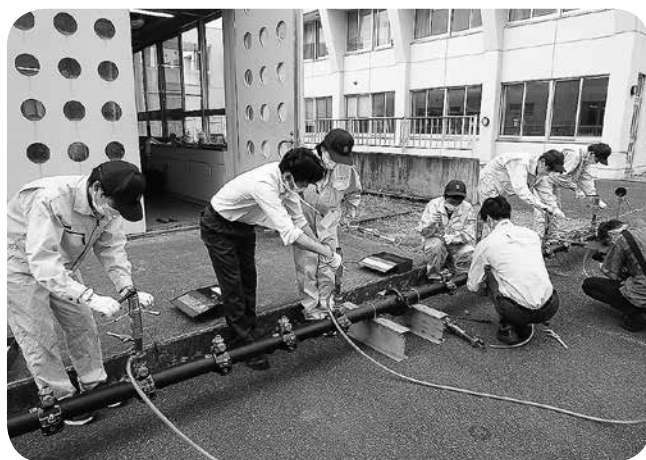
サドル付き分水栓施工の様子
