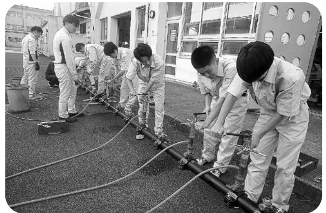
サドル付き分水栓施工
