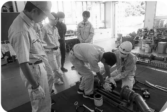
ダクティル鋳鉄管の接合
