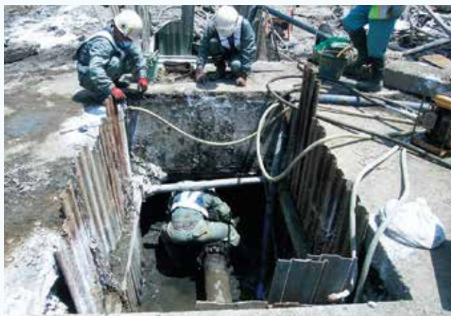
DIPΦ200上水道管復旧状況(石巻市魚町地区)
