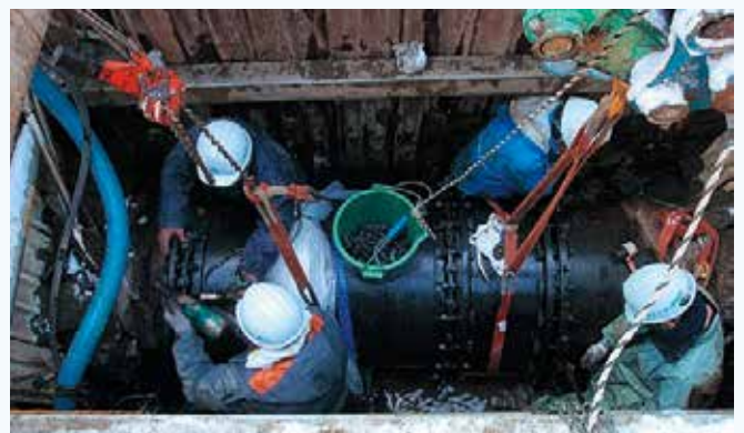
復旧(修繕)状況 国見第二配水幹線(仙台市水道局提供)
