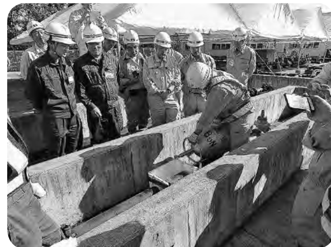
液体窒素で管内の水を凍結
