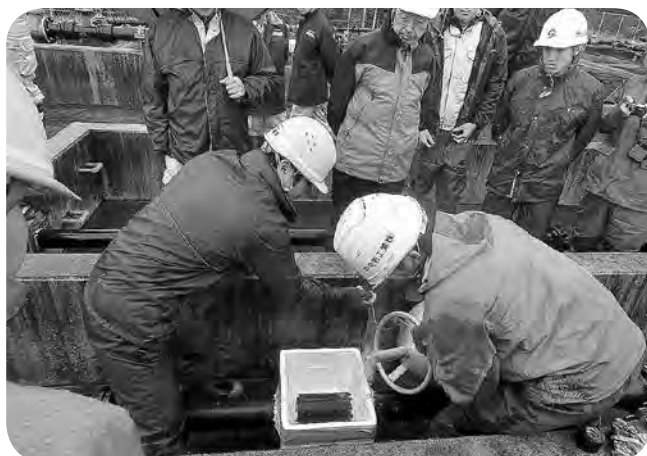
液体窒素で管内の水を凍結
