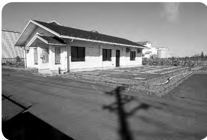
農集排水事業の一例：四ツ谷クリーンセンター（若林区）
