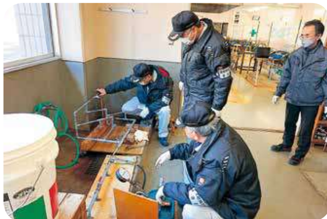
水圧検査の様子
