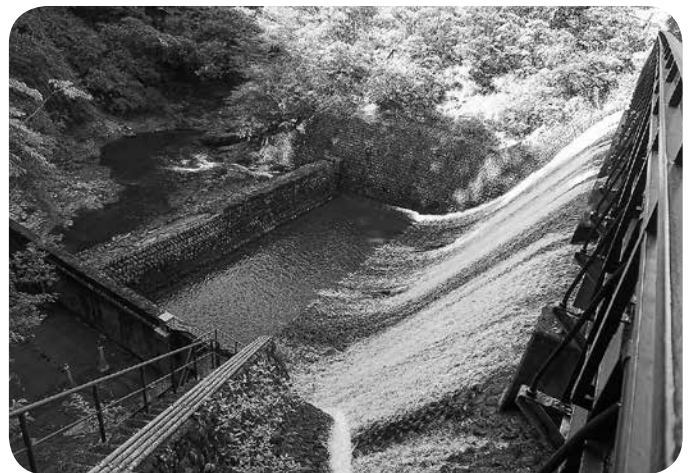
青下第一ダム
