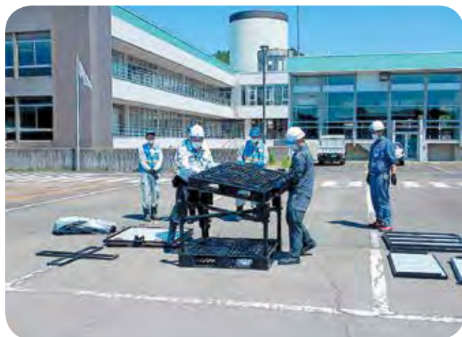
②仮設水槽を組立
