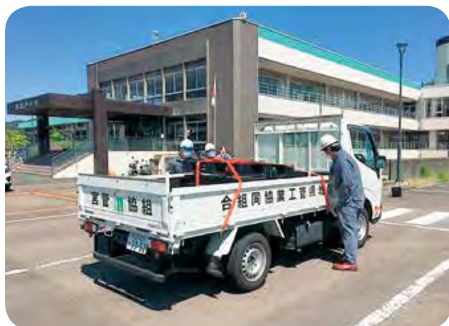
①仮設水槽を運搬
