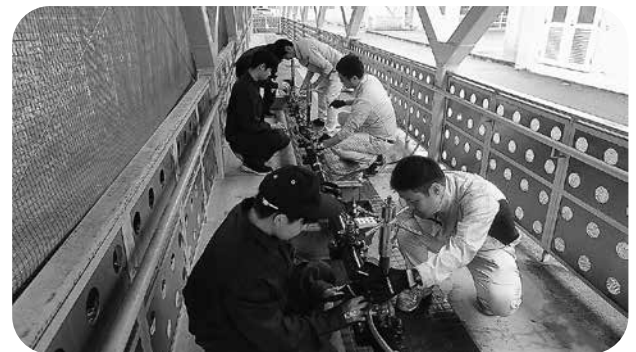
サドル付き分水栓の施工
