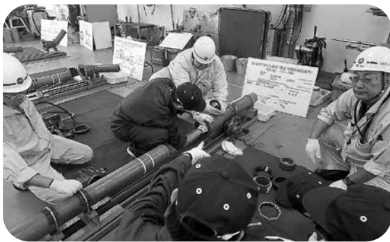
ダクタイル鉄管の接合
